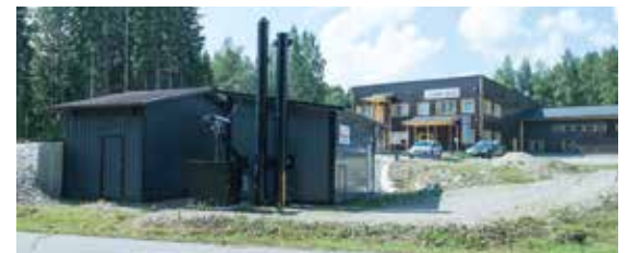
Paikallinen lämpöyrittäjä huolehtii pienestä hakelämpökeskuksesta, joka tuottaa lämpöenergiaa tehtaan kulutushuippuihin.
