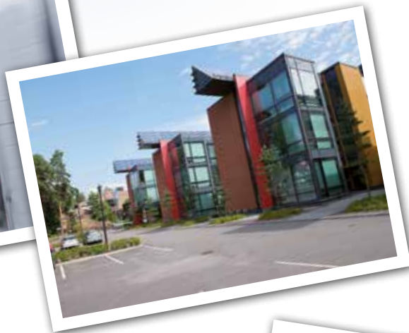
Vaisala hyödyntää aurinkoenergiaa yhteensä 100 kW:n paneelit pääkonttorin katoilla ja seinillä tuottavat noin 20% rakennuksen vuotuisesta sähköenergian tarpeesta.
