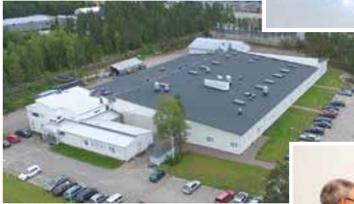
▲ 2016 Haapaveden tehtaan 3. laajennus valmistuu.
